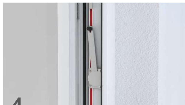
2 Устанавливаем ограничитель в раме окна на расстоянии около 160 мм от ответной планки (очень важно чтобы конец ножки находился около 30 мм под ответной планкой).
